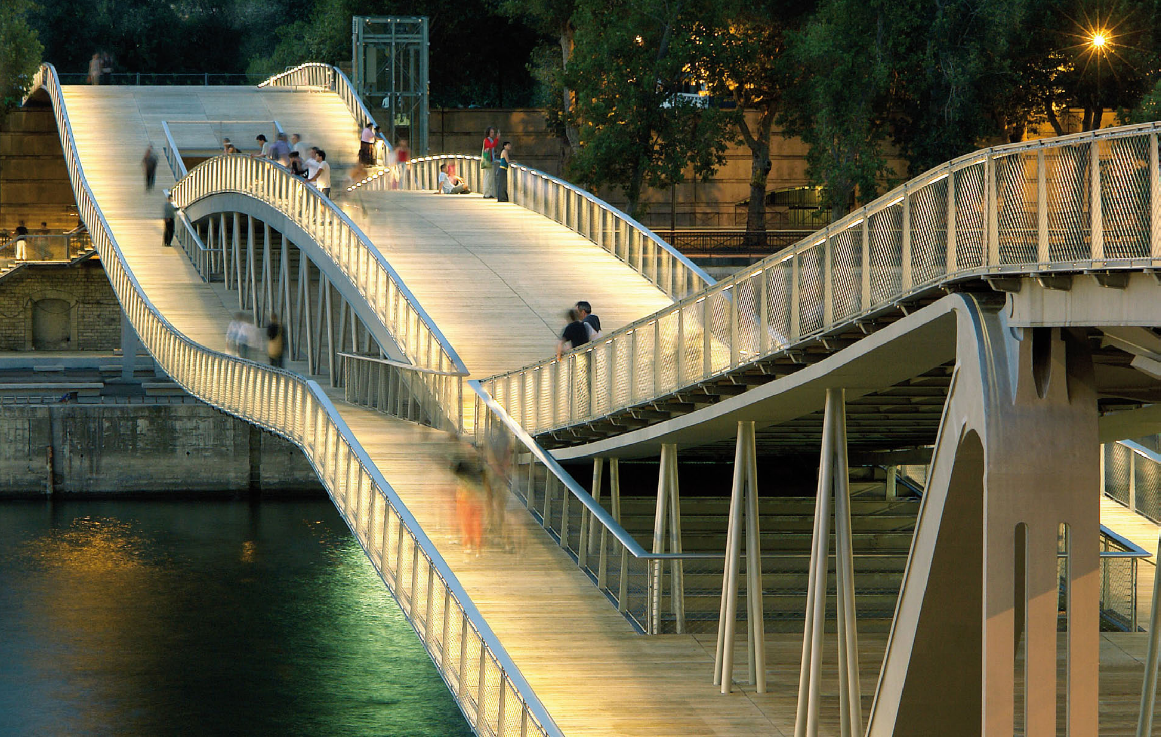
Dietmar Feichtinger Architectes Passerelle Simone-de-Beauvoir, Paris, 2006 Foto: David Boureau
